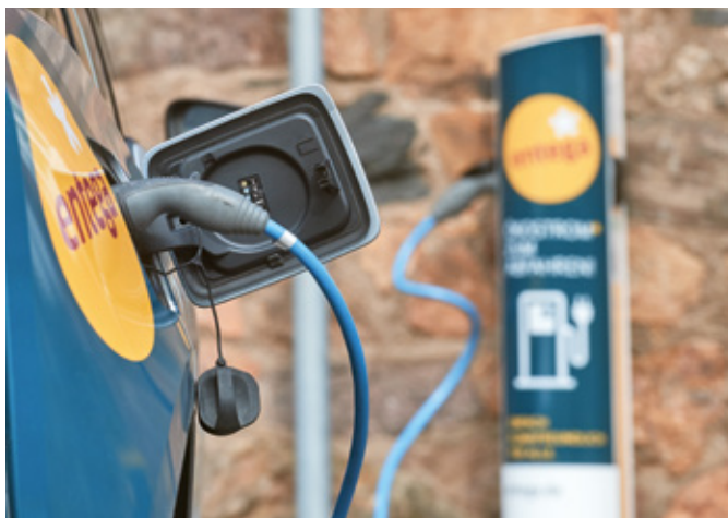
2017 hat ENTEGA über 100 neue Ladestationen in der Region in Betrieb genommen.
